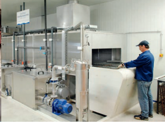
Individuelle Vorbehandlung der Oberflächen
